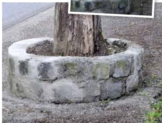
Travaux de réfection en maçonnerie des bordures autour des arbres Rue Castel effectués par le service technique municipal.
