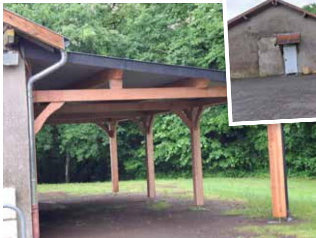
Travaux de remplacement de l'auvent de la Salle Kibboutz pour un coût de 23 334,60 €TTC
