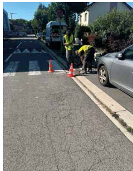
Installation des plots routiers solaires
